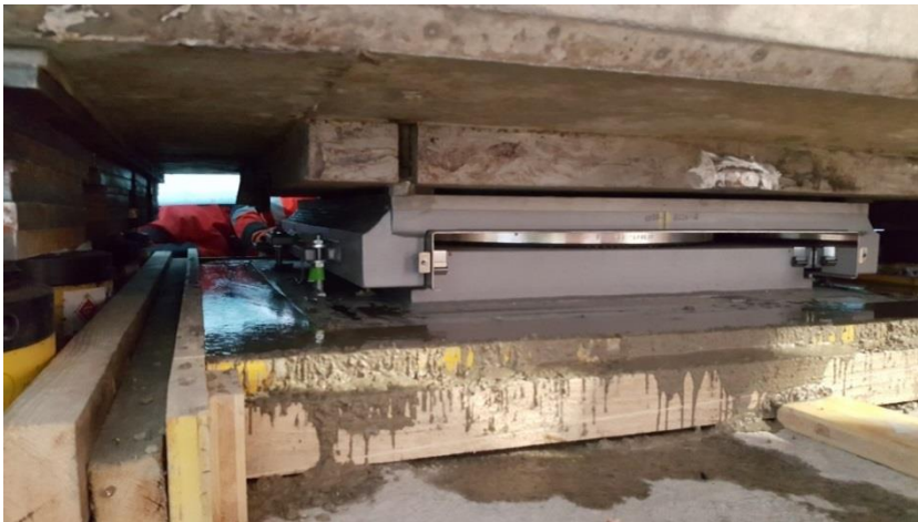
Abbildung 13: Verguss zum Betonunterbau, Anschweißen am Stahlüberbau
