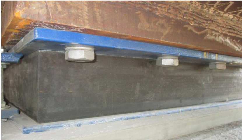
Abbildung 15: Verguss zum Betonunterbau, Schraubenverbindung zum Stahlüberbau
