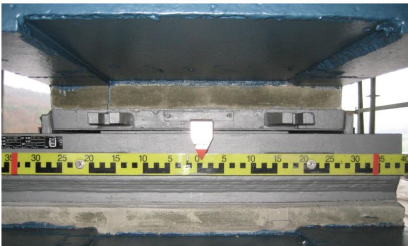
Abbildung 14: Verguss zum Stahlunterbau, Verguss zum Stahlüberbau
