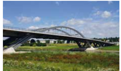
Waldschloesschen Bridge, Dresden / Germany
