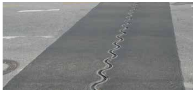
Juntas de dilatación de perfil simple con insonorización de MAURER
