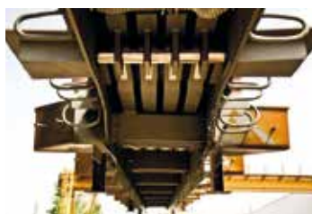
Junta travesaño en batería de MAURER
