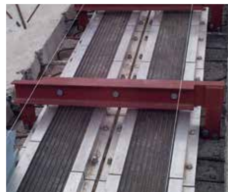
Instalación de las juntas de dilatación dobles de MAURER
