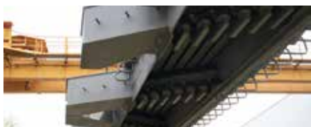
Junta con travesaño giratorio modular de MAURER extendida
