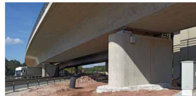
Instrumentiertes Lager an der Achse 40 Rechts: Blick in den Hohlkasten der Brücke, im Vordergrund Sensorkabel
