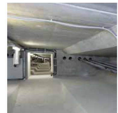
Instrumentiertes Lager an der Achse 40 Rechts: Blick in den Hohlkasten der Brücke, im Vordergrund Sensorkabel
