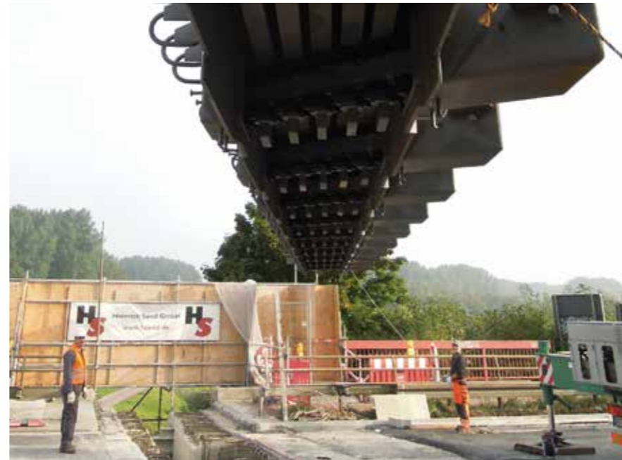
Anlieferung der Dehnfuge
