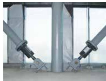
Die Dämpfer sitzen am unteren Ende der Querstreben. Sie sind 750 mm lang.
