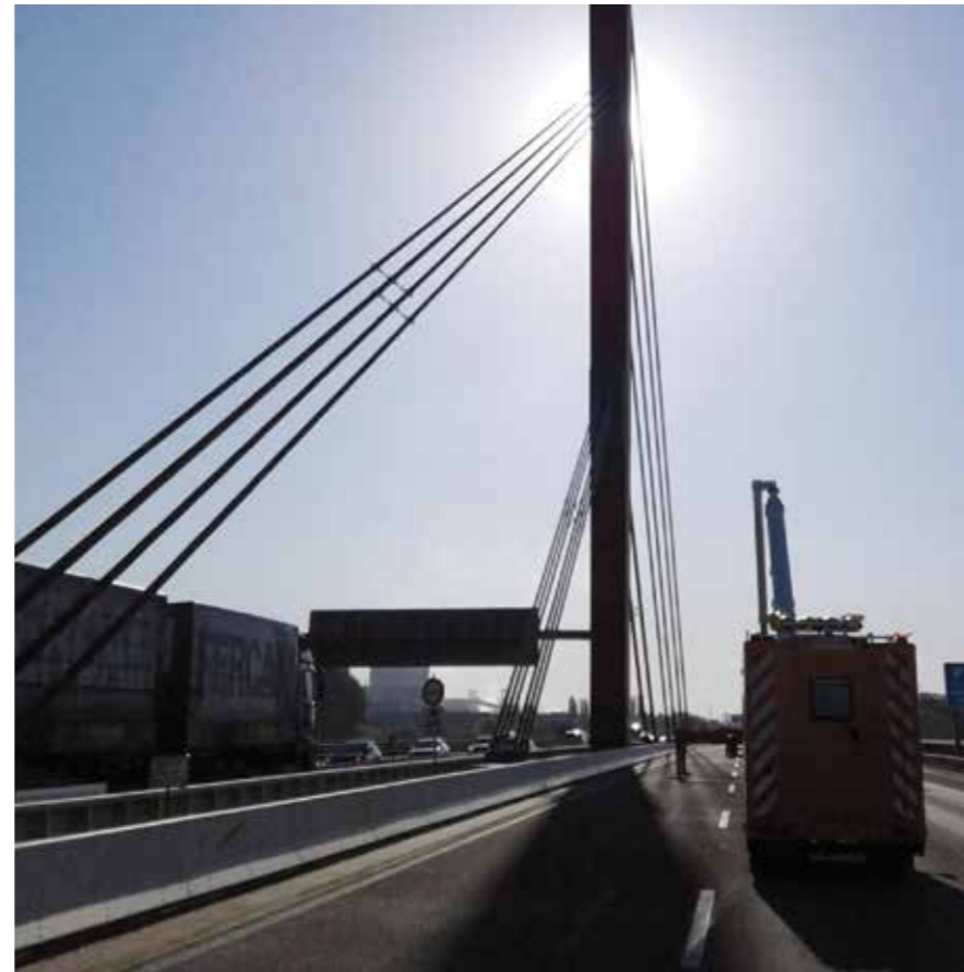
Dramatisch schön – die Beckerwerther Brücke
