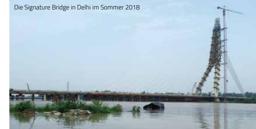
Die Signature Bridge in Delhi im Sommer 2018
