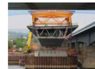
Die neue Schiersteiner Brücke während der Bauarbeiten
