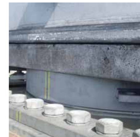
Die Auflager unter der Bogibil-Brücke übertragen auf kleinstem Raum 2.800 t Last.
