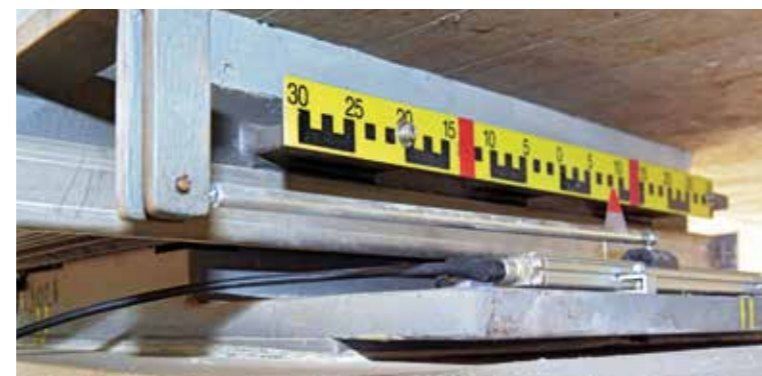
Kalottengleitlager KGA mit Verschiebungsmessung
