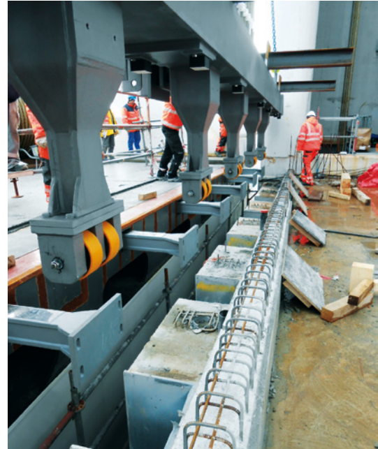
Die Untersicht einer Übergangskonstruktion mit riesigen Pins als Zentriervorrichtung. Die gelben Rollen dienen als Gleiteinheiten.
