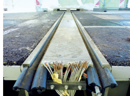
Teststand einer intelligenten Schwenktraversen-Dehnfuge, die Achslasten mit einer Genauigkeit von 10% ermittelt.
