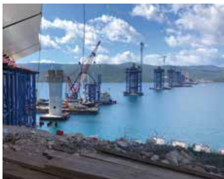
September 2020: Blick hinüber zur Halbinsel Pelješac. 2022 soll die Brücke eingeweiht werden.
