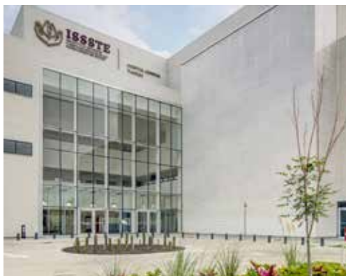
Das Hospital de Tláhuac kurz vor Inbetriebnahme. Gut zu erkennen die drei Gebäude, die auf einer gemeinsamen Plattform stehen. Die Erdbebenisolatoren liegen unter der Plattform.
